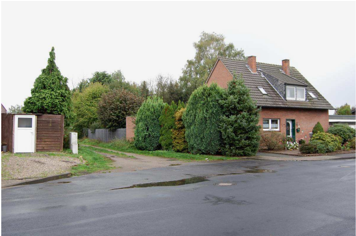
Abbildung 10: Wohngebäude 'Meursfeldstraße 15' (projektierter Zufahrtbereich/östliche Plangebietsgrenze)
