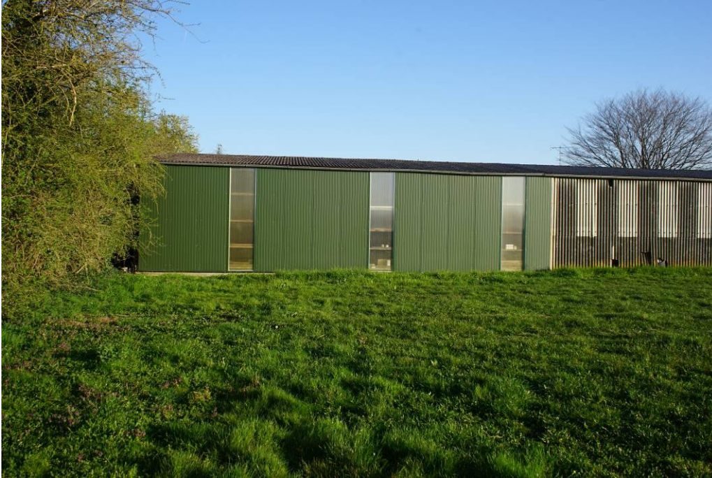
Foto 7: Südfassade der bestehenden Maschinenhalle aus Trapezblechen bzw. Faserzementplatten
