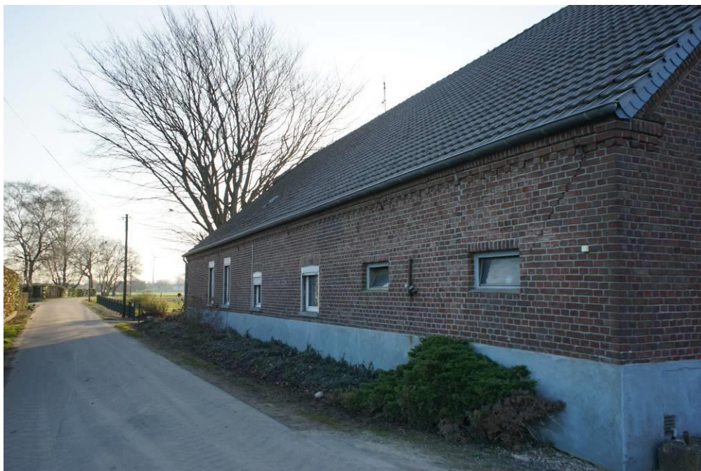
Foto 1: Bauernhaus Im Heidkamp 23 mit Wohn- und Werkstattteil
